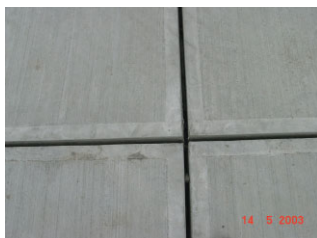
Bild 1. Ortbetonbelag mit Besenstrichoberfläche und Drainagefugen, die mit Rundschaumschnur und elastischer Versiegelung verschlossen werden
