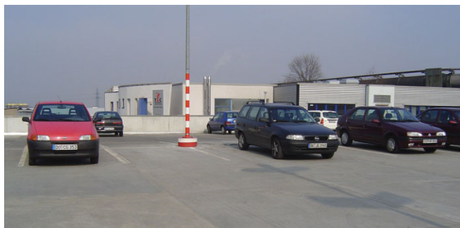
Bild 5. Helle, freundliche Parkfläche mit Lichtmastsockel und Anprallschutz – das Gefälle ist zu den Rinnen orientiert und garantiert den schnellen Abfluß (Fotos: El Diwany-Himstedt)
