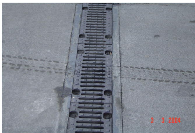
Bild 4. Entwässerungsrinne – der Rinnenrahmen ist in Einzellängen auf das Plattenmaß abgestimmt
