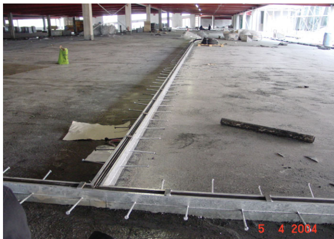
Bild 3. Fugenkonstruktion auf einer stark beanspruchten Fläche
