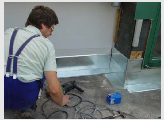
Neue Verblechung als Abdichtungsrücklage auf der Terrasse
