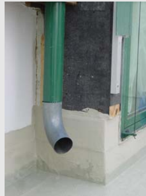
Neue Verblechung als Abdichtungsrücklage auf der Terrasse
