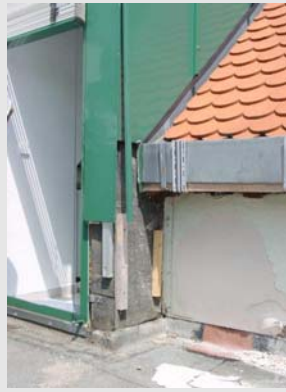
Neue Verblechung als Abdichtungsrücklage auf der Terrasse
