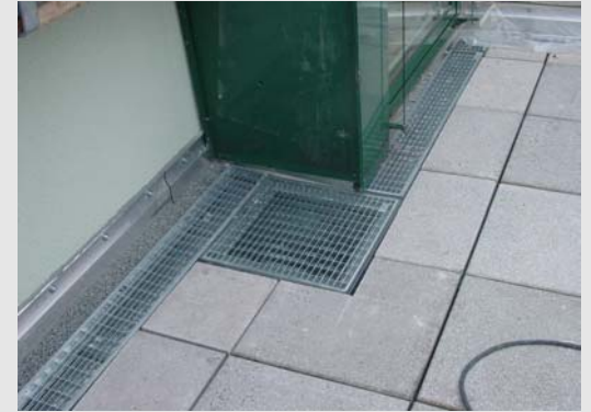
Neue Verblechung als Abdichtungsrücklage auf der Terrasse
